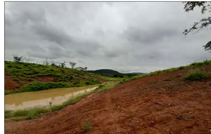
Figura - Vista geral de barramento presente na área de intervenção ambiental. Fonte: Vetor Soluções Ambientais, 2020.
